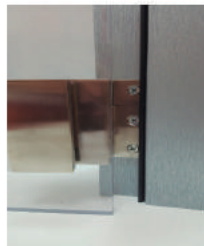
BISAGRA DE PUERTA PARA APERTURA HACIA DENTRO Y HACIA FUERA VISTA POR EL INTERIOR
