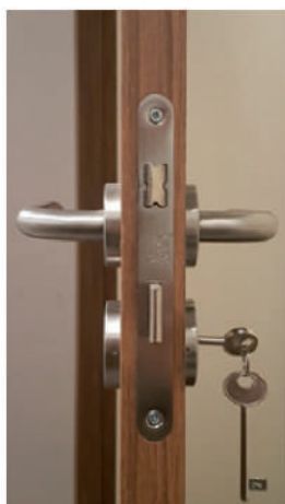
CANTO CHAPADO CON CERRADURA DE LLAVE BORJA
