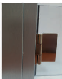
BISAGRA DE PUERTA PRACTICABLE VISTA POR EL INTERIOR
